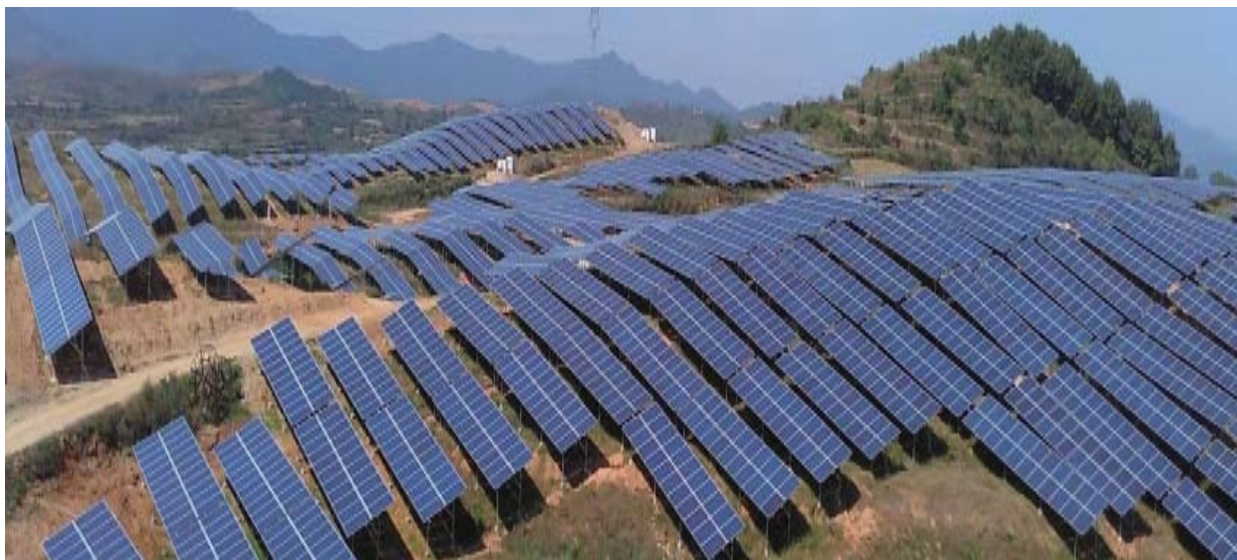
Usina Fotovoltaica de 30MW em Hong'an
