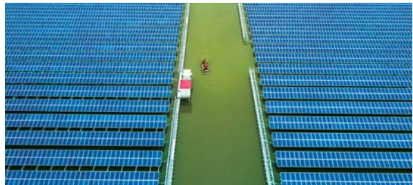
Maior Usina Fotovoltaica flutuante do mundo de 200MW no reservatório de Zhejiang Cixi
